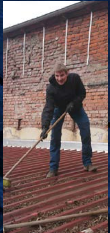
Zum Objektpflege gehört auch „Frühlingsputz“, hier putzt Leonhard Nebig fleißig das Dach.
