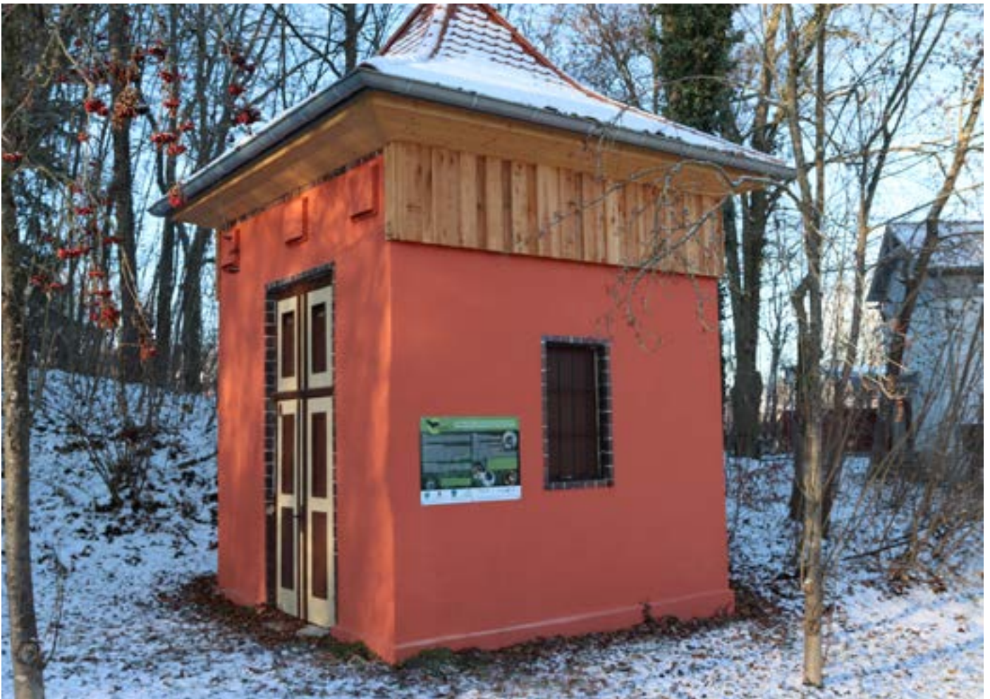
Ein Brunnenhäuschen wurde saniert und in ein Fledermaushotel umgestaltet.
