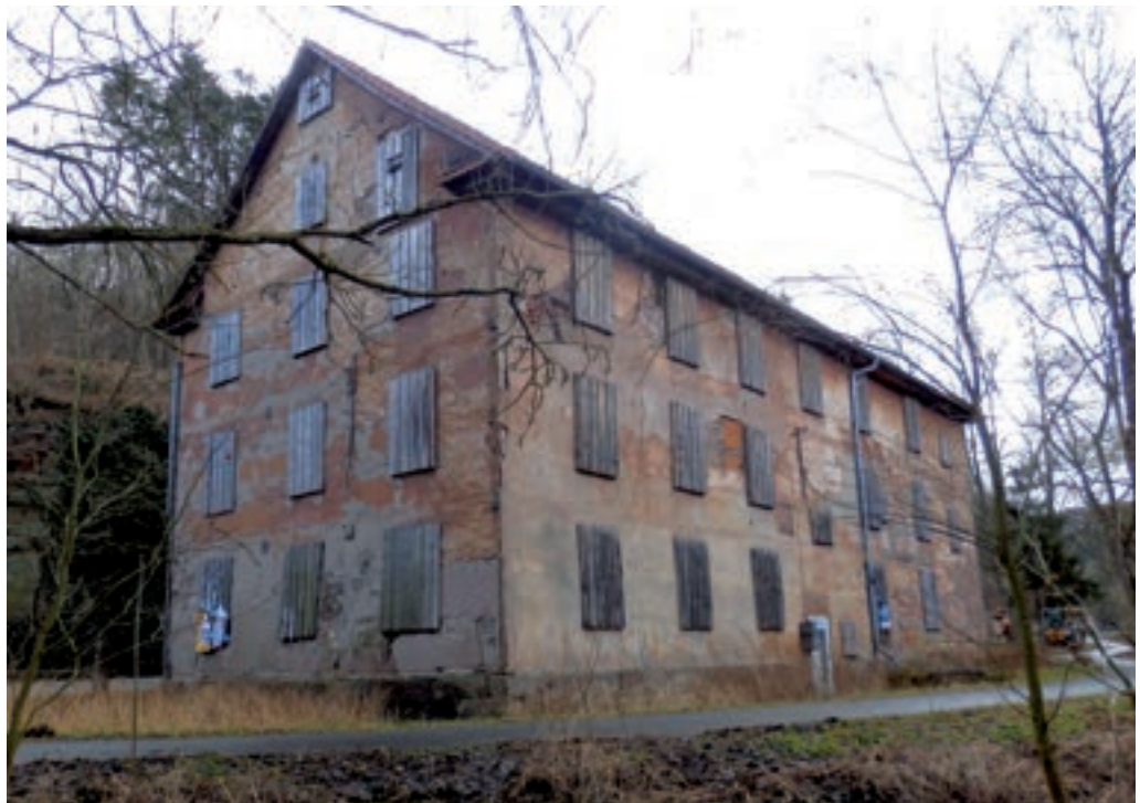
Die Wiesenmühle in Marth (Thüringen) vor Beginn der Baumaßnahmen.
