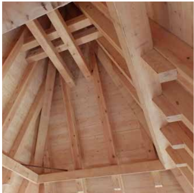
Blick in die neue Turmhaube, den Haupthangplatz der Mausohren, hier noch ohne Innenverkleidung.
