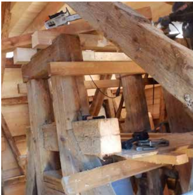
Ein Mitarbeiter der Firma Pfeiffer aus Berlstedt bei Fachwerkarbeiten am Glockenstuhl der Kirche.
