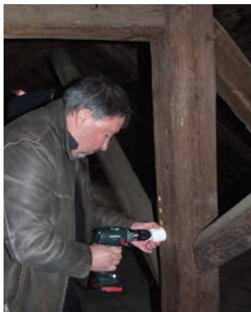
*Projektpartner Holger Niewisch bei der Entnahme von Bohrkernen in der Kirche Bürgel bei Jena. Der Dachstuhl der Mausbrüchchenstube ist mit DDT belastet.*
